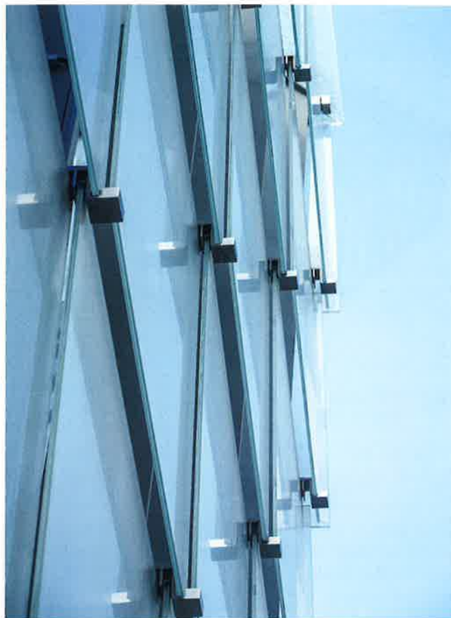
Bild 11 Detailsicht Glasfassade mit Punkthaltern Detail of the glass facade with point fixings
