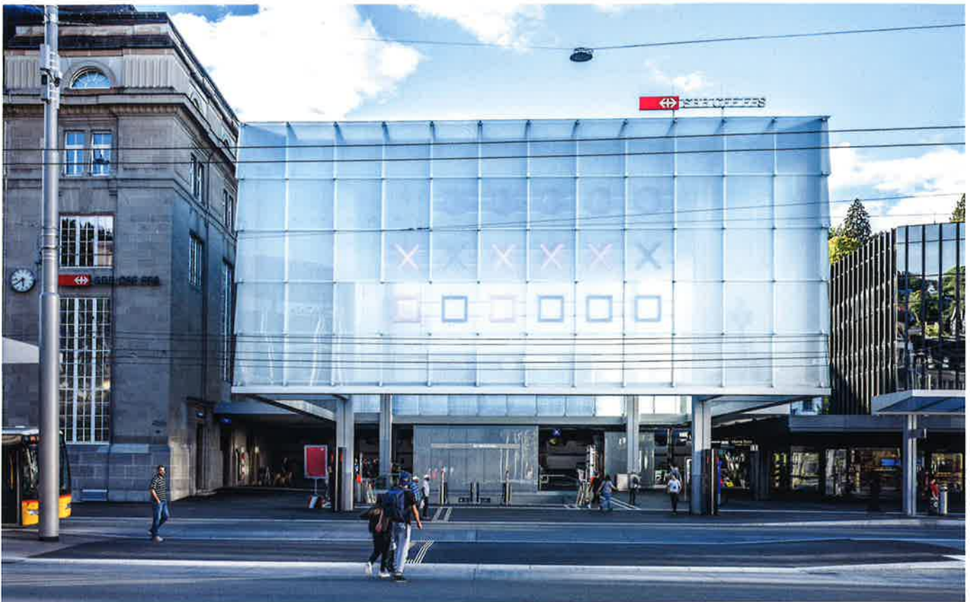
Bild 14 Bahnhofplatzseitige Ansicht der Ankunftshalle View of the arrival hall from Bahnhofplatz
