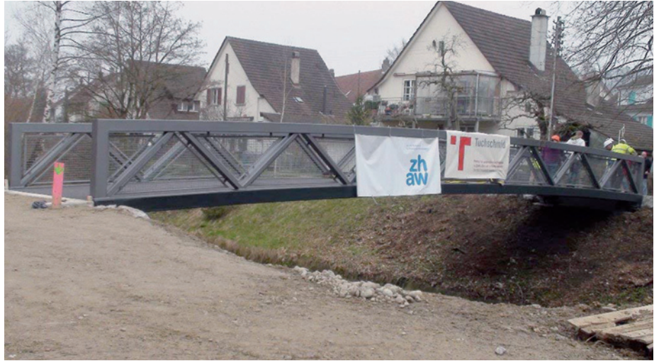
In die Widerlager positionierte Brücke.
