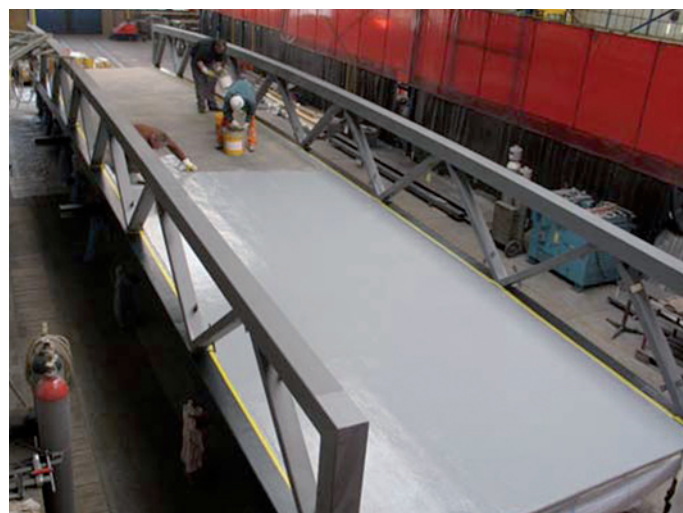
Aufbringen des Dünnschichtbelags.
