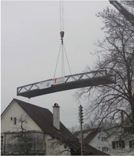
Einheben der Brücke mit einem mobilen Kran.
