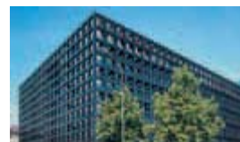
La Ferriera, Locarno Bauherrschaft: Swiss Life, Zürich Architekten: Livio Vacchini Ingenieure: Andreotti + Partners Stahlbau: Mauchle Metallbau European Steel Design Award 2005
