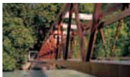
Limmatsteg mit Promenadenlift, Baden-Ennetbaden Bauherrschaften: Stadt Baden und Gemeinde Ennetbaden Architekten: Leuppi & Schafroth Ingenieure: Henauer Gugler Stahlbau: Zwahlen & Mayr
