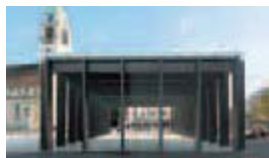
Markthalle Kirchplatz, Dietikon Bauherrschaft: Stadt Dietikon Architekt: Prof. Ueli Zbinden Ingenieur: Funk + Gutknecht Stahlbau: Tuchschnid
