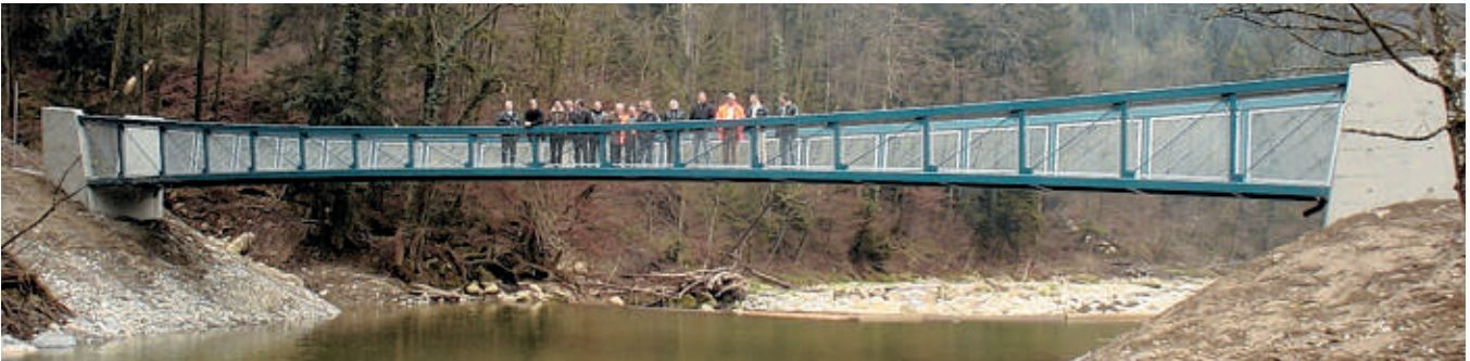
Abb. 4: Schifflibrücke anlässlich der Schlussabnahme.
