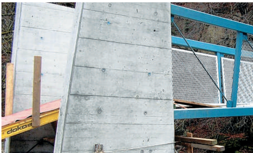
Abb. 3: Verankerungsdetail Obergurt und fertiggestellte Widerlagerscheiben.
